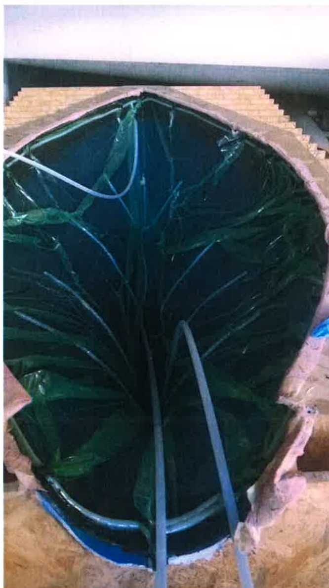
Slika 5: izvedba infuzije, Tehnol d.o.o, Izola
